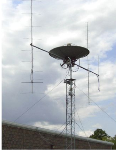
Figura 4.3 - Estrutura das antenas para comunicação em VHF e Banda-S do nanosatélite CanX-2 instaladas no topo do prédio principal da UTIAS em Toronto, Canadá.
